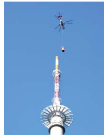
Mit einem Lastenbubschrauber werden die neuen Antennen für das digitale DVB-T: Das ÜberallFernsehen Stück für Stück auf die Sendemasten aufgesetzt. (Foto: N. Schulze, MDR)
